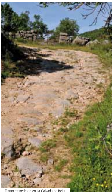
Tramo empedrado en La Calzada de Béjar
